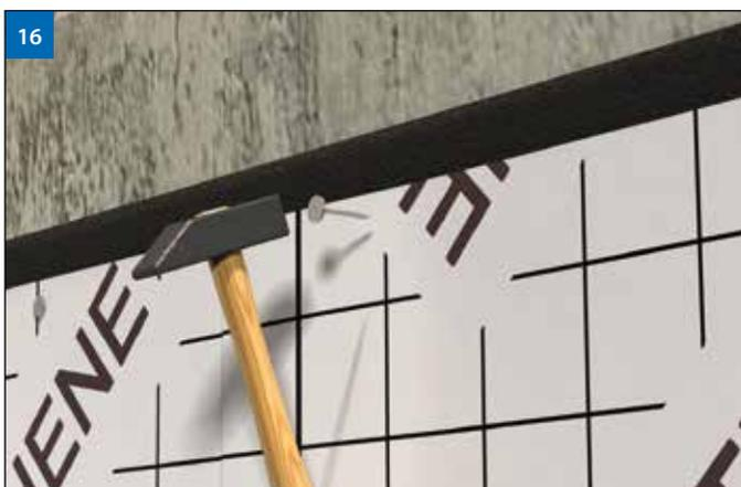
*(Рис. 16)* Однако необходимо дополнительно механически закрепить верхнюю кромку мембраны DELTA®-THENE к стене. Например, если стены подвала выложены из кирпича, верхнюю кромку можно закрепить гвоздями с широкой шляпкой с шагом 50 см. После зону фиксации проклеить лентой DELTA®-FLEXX-BAND, на которую впоследствии можно нанести штукатурку.
