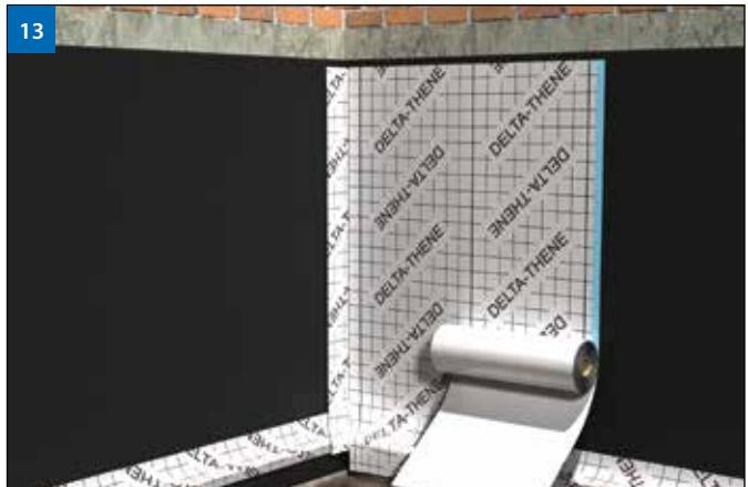
(Рис. 13) При установке следующих рулонов мембраны следует проверить вертикальную линию, как описано выше, и наклеить рулоны с нахлестом 10 см.
