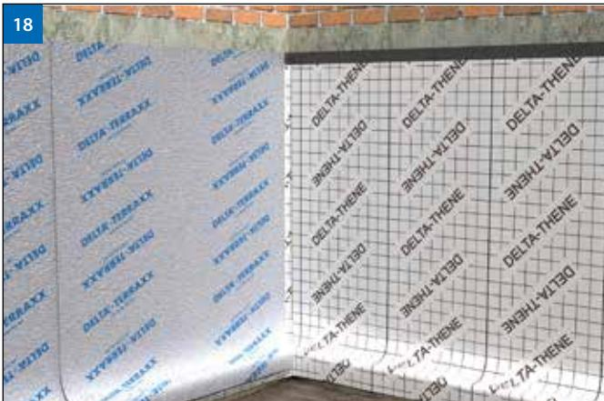
(Рис. 18) Для защиты гидроизоляционной мембранны от механических повреждений во время обратной засыпки следует использовать DELTA®-TERRAXX. Эта дренажная мембрана обеспечивает надёжную защиту и отличный пластовый дренаж.
