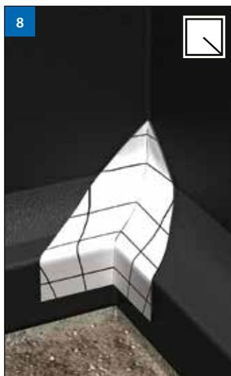
(Рис. 8) Для внутренних углов подготовить квадратный кусок размером около 30 x 30 см и прорезать от середины до вершины. Далее сформировать треугольную заготовку в виде угла и наклеить на галтель. Затем вырезать квадратную заготовку от угла до середины и сверху наклеить в угол на первую заготовку.
