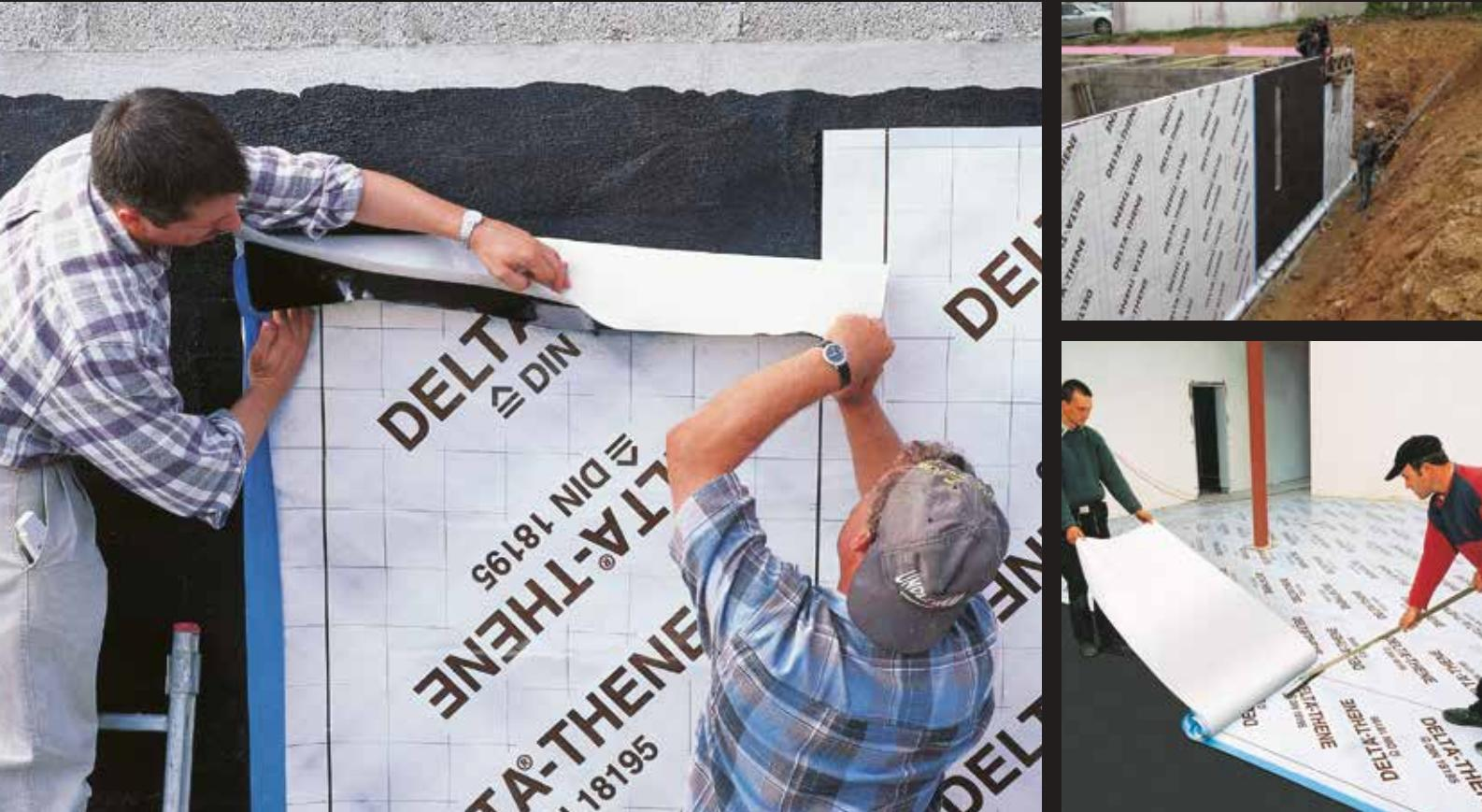
Система гидроизоляции для горизонтального
