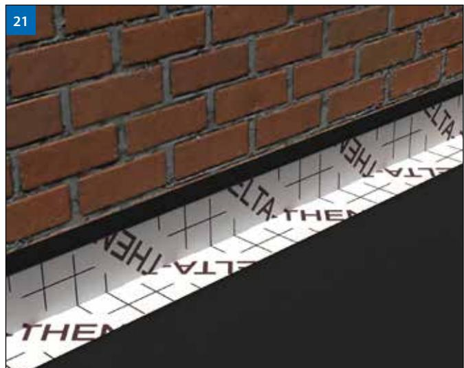
(Рис. 21) По линии перехода от изолируемой плиты к стене наклеить усиливающую полосу шириной не менее 30 см.
