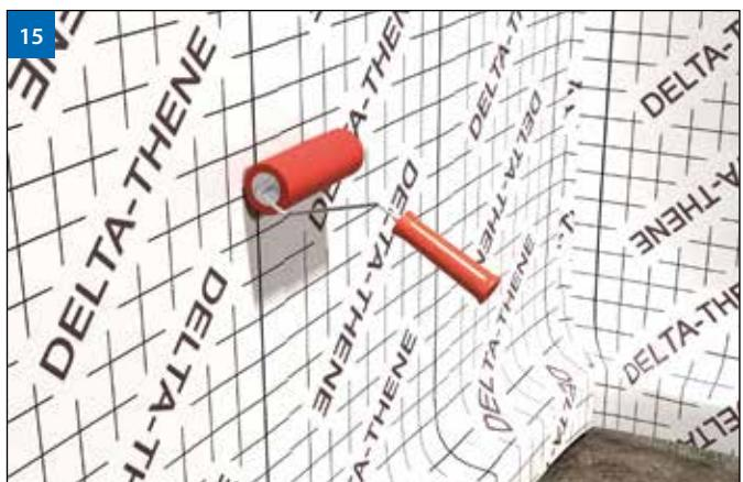
(Рис. 15) Любые нахлести, примыкания и проходки тщательно наклеивать и прижимать, не допуская образования воздушных полостей и пузырей.
