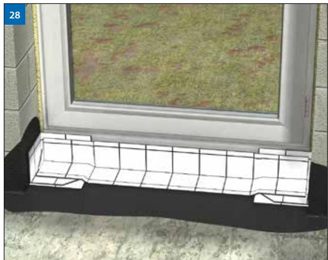
(Рис. 28) Наклеить усиливающие полосы (заготовки или готовые ленты DELTA®-THENЕ-BAND T 300). Ширина усиливающих полос должна быть около 30 см. У ленты DELTA®-THENЕ-BAND T 300 защитная бумага состоит из двух частей и разделена посередине. Вытянуть одну половину и приклеить ленту. После прижать вторую часть ленты к основанию, вытянуть оставшуюся защитную полосу бумаги и полностью наклеить ленту на угловые фасонные детали.
