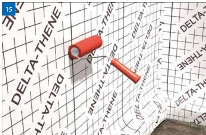
(Рис. 15) Любые нахлесты, примыкания и проходки тщательно наклеивать и прижимать, не допуская образования воздушных полостей и пузырей.
