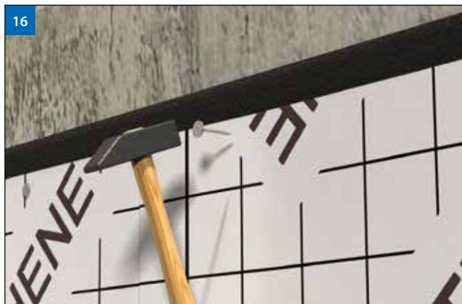
(Рис. 16) Однако необходимо дополнительно механически закрепить верхнюю кромку мембраны DELTA®-THENE к стене. Например, если стены подвала выполнены из кирпича, верхнюю кромку можно закрепить гвоздями с широкой шляпкой с шагом 50 см. После зоны фиксации проклеить лентой DELTA®-FLEXX-BAND, на которую впоследствии можно нанести штукатурку.
