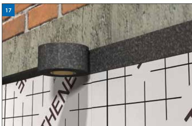
(Рис. 17) При использовании ленты DELTA®-FLEXX-BAND минеральные поверхности обработать грунтовкой DELTA®-THENE-GRUNDANSTRICH и дать высохнуть. Применение планок или цокольных шин также возможно, они должны быть установлены сразу после наклейки мембранны DELTA®-THENE.
