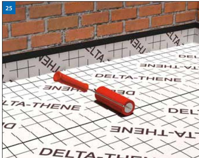
(Рис. 25) Все нахлёсты, примыкания и проходки тщательно прокатать роликом, не допуская образования воздушных полостей и пузырей.
